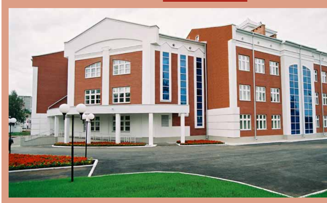
Город Волжский, Республика Удмуртия. Детская школа искусств. Генпроектировщик – ОАО «Прикамский институт проектирования промышленных предприятий» (ОАО «Прикампромпром»), г. Ижевск – член НП СРО МОПРОСС (ip-mopross.ru). Расположено на пересечении улиц 1-й Мия и Кирова. Трехэтажное здание имеет общую площадь 3960 кв. м, сдано в эксплуатацию в 2005 году. Специализированное внешнее учреждение рассчитано на 290 учащихся, ориентировано на раннюю профессионализацию наиболее одаренных детей в области живописи, музыки и хореографии.
