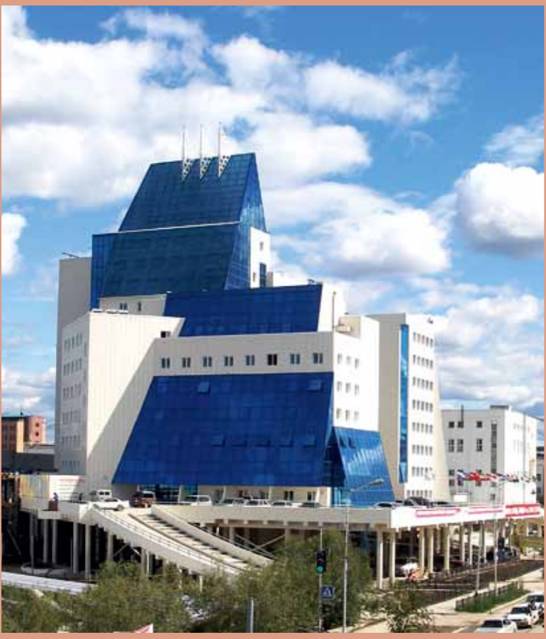
Город Якутск. Бизнес-центр «МУУС» (муус – в переводе с якутского: лед, вода). Авторы – Шингин Ф.И., Макарова Л.К., Иванова А.Н. Введен в эксплуатацию в 2009 г. Строительный объем 99 424 куб.м. Общая площадь 25 671,5 кв.м. Проектировщик – ОАО «Якутгражданпроект» (член СРО НП «Северный проектировщик», г. Якутск). По оценкам специалистов, для Якутска, который расположен в условиях вечномёрзлых грунтов и с учетом непростой сейсмичности, этот проект является достаточно непростым и смелым.
